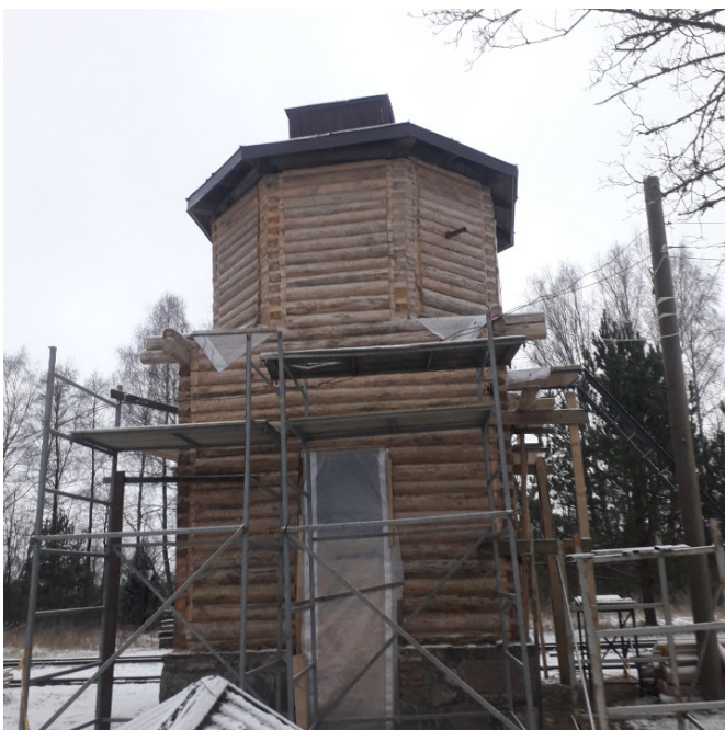
1 pav. Esama vandentiekio bokšto būklė
